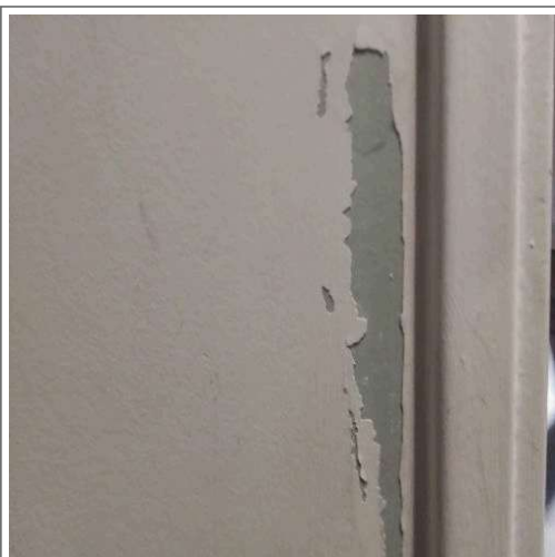
Dégagement meublé : Mur accès : Peinture
