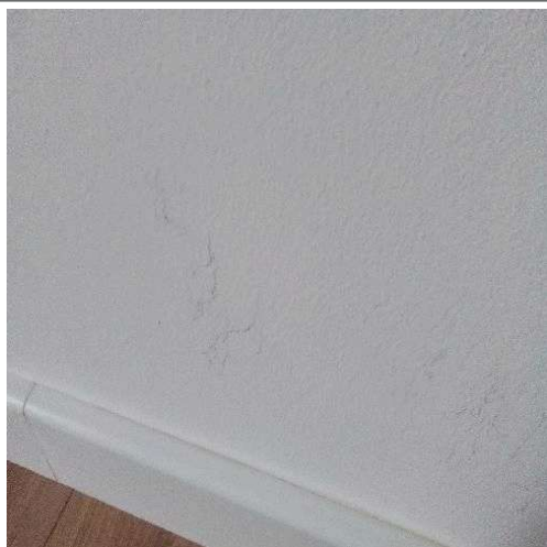
Chambre meublée 2 : Mur droite : Peinture
