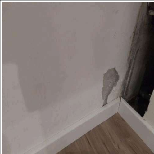
Dégagement meublé : Mur face : Peinture
