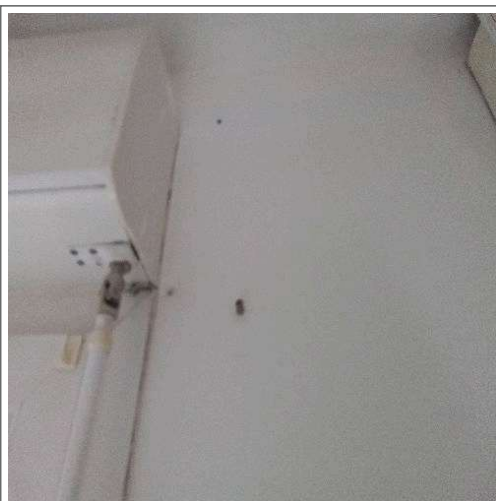
Chambre meublée 2 : Mur face : Peinture
