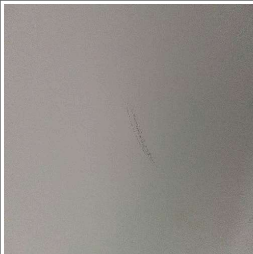
Chambre meublée 2 : Mur face : Peinture
