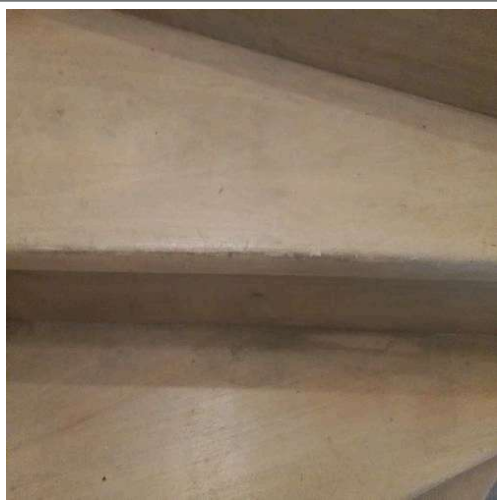
Escalier : Marches : bois
