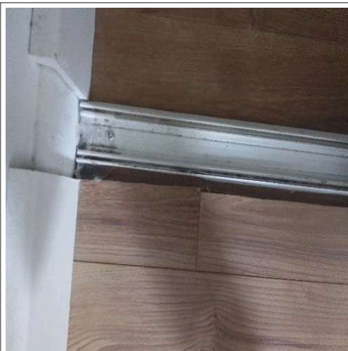
Chambre meublée 1 : Placard : Rail de guidage
