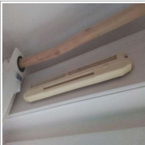
Chambre meublée 2 : Ventilation : sur coffre de volet
