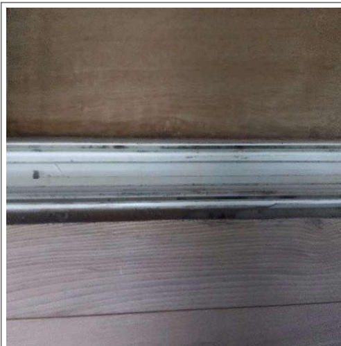
Chambre meublée 2 : Placard : Rail de guidage
