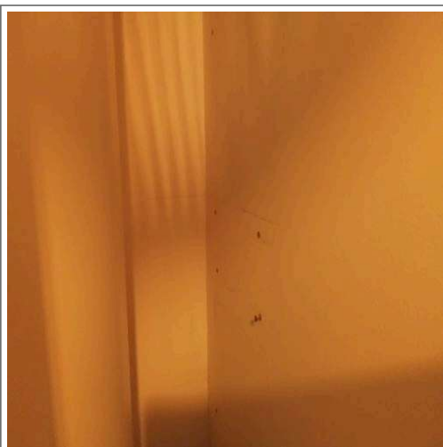
Wc : Placard : intérieur peint
